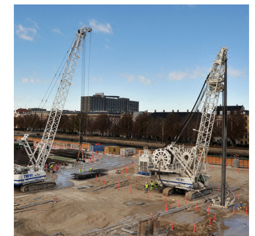
Fundaciones del metro de Copenhague - Dinamarca
