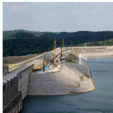
Messa in sicurezza diga Wolf Creek, Kentucky- USA
