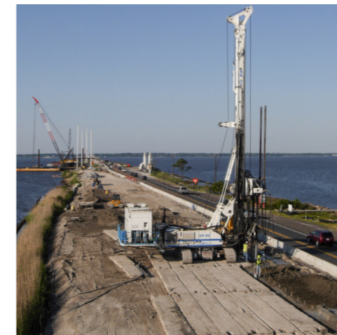
Autostrada US 331 Florida - USA
