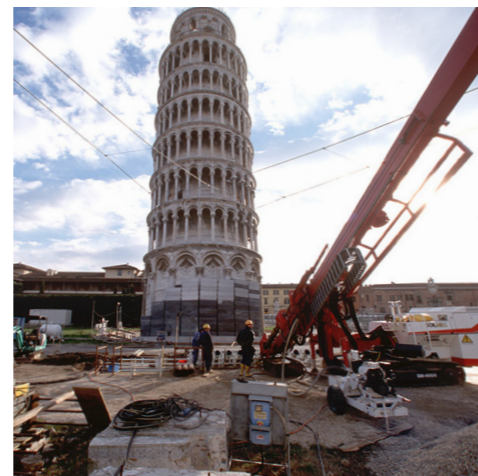
Messa in sicurezza Torre di Pisa - Italia
