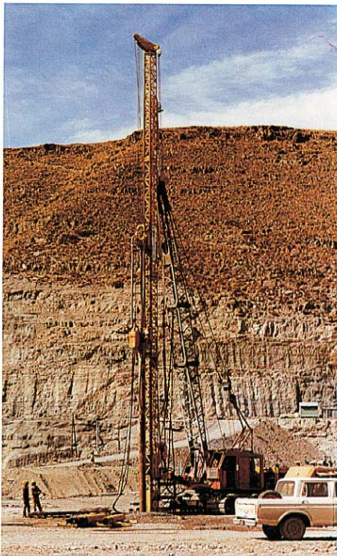
Costruzione pozzi di alivio Construction of relief wells
