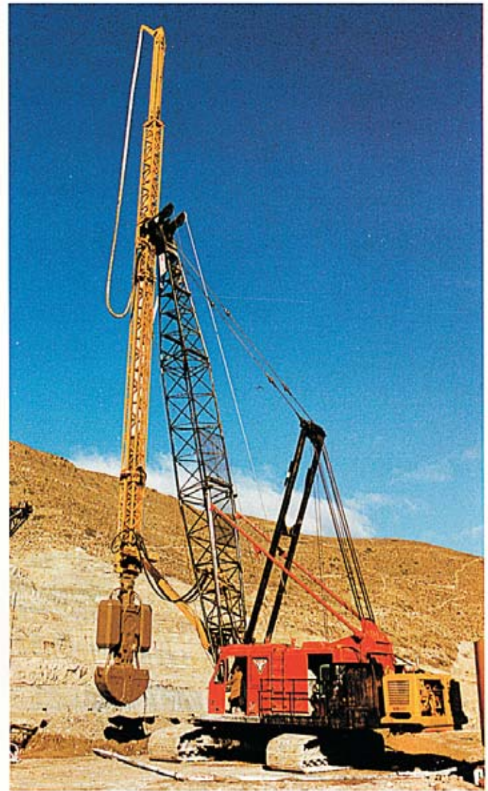
Costruzione diaframma plastico Construction of plastic cut-off
