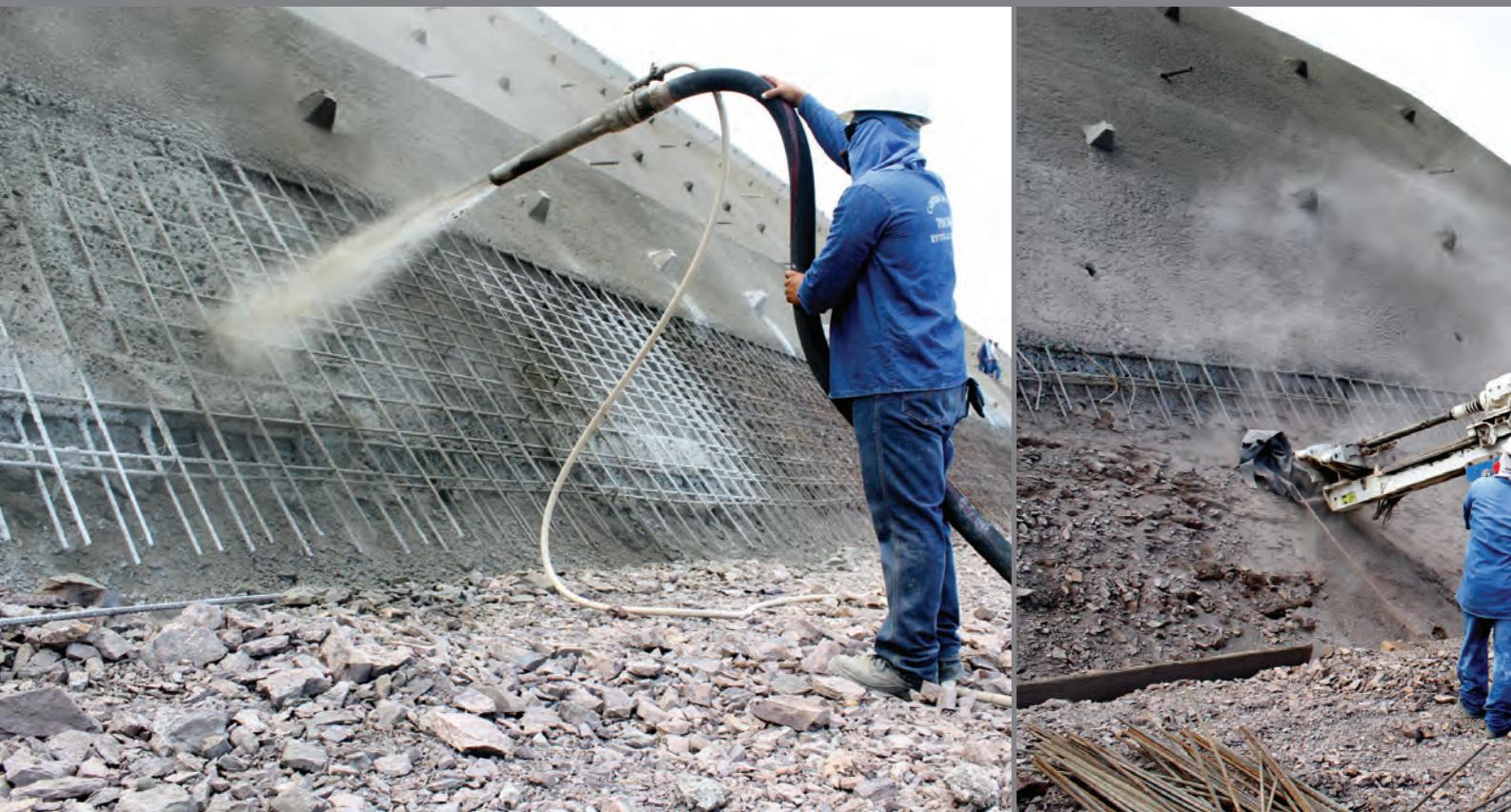
25 cm, fissato al versante mediante ancoraggi di tipo PERMANENTE, tensati con una carica di servizio con P=30 t, con separazione orizzontale di 3mt e in senso verticale sono previste minimo 3 file di ancoraggi per 10 mt di altezza del versante. Ogni tirante sara` costituito da un minimo di 3 guaine da 5/8" 270-k.
