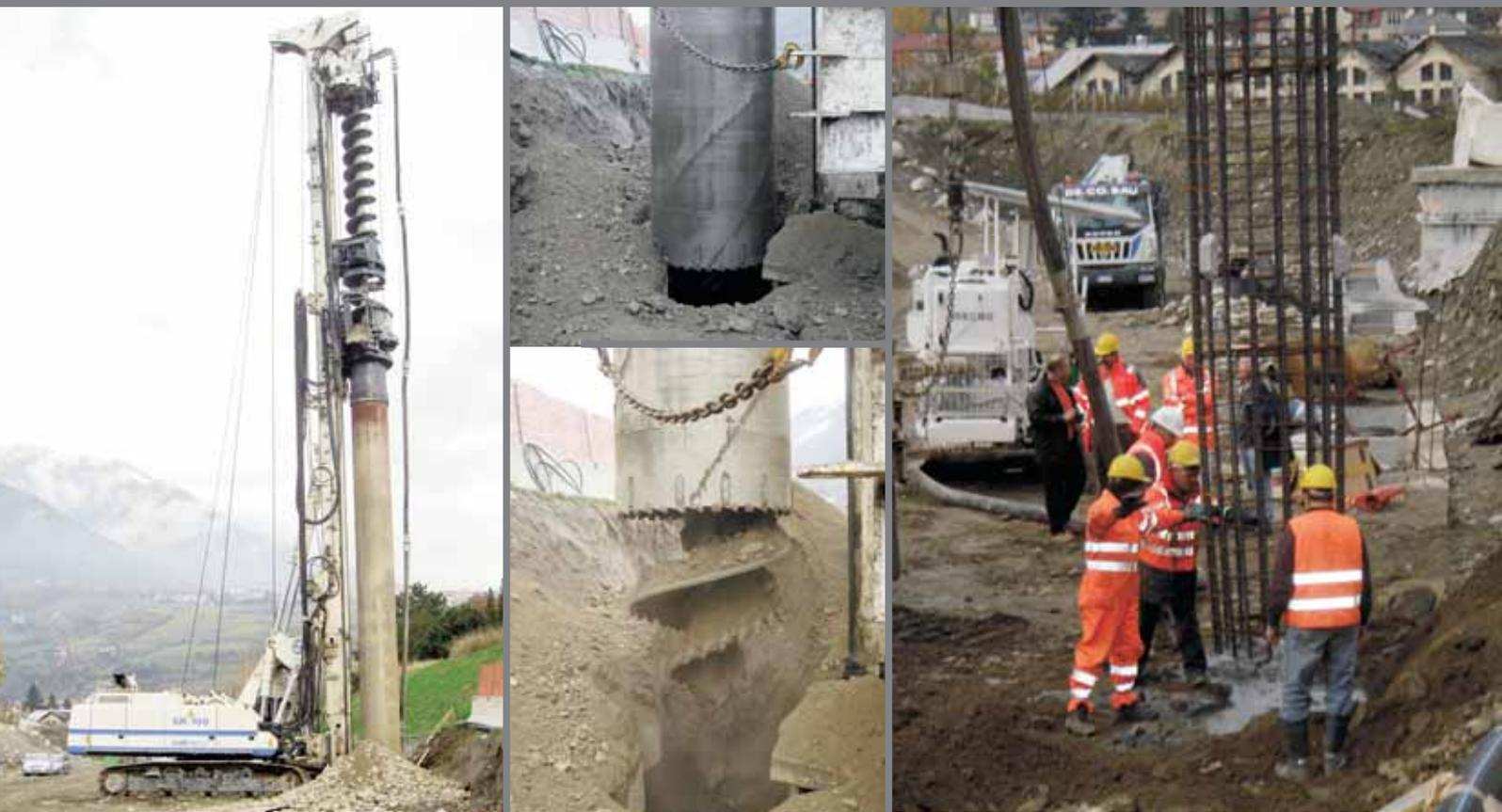
In effetti, a prescindere della protezione con tubo, solo l'idea di perforare ad elica continua in tale terreno, come avviene con il metodo CAP, costituiva una vera scommessa. Invece, in base ai diametri da realizzare, Trevi ha utilizzato macchine SOILMEC SR-80, CM-120 e SR-100, tutte allestite in configurazione CAP con doppia testa.
