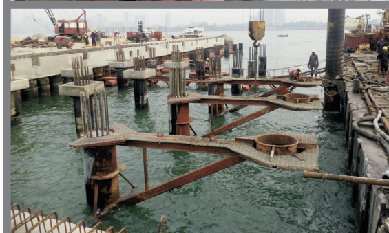
Guida pali della banchina / Deck piles guides
