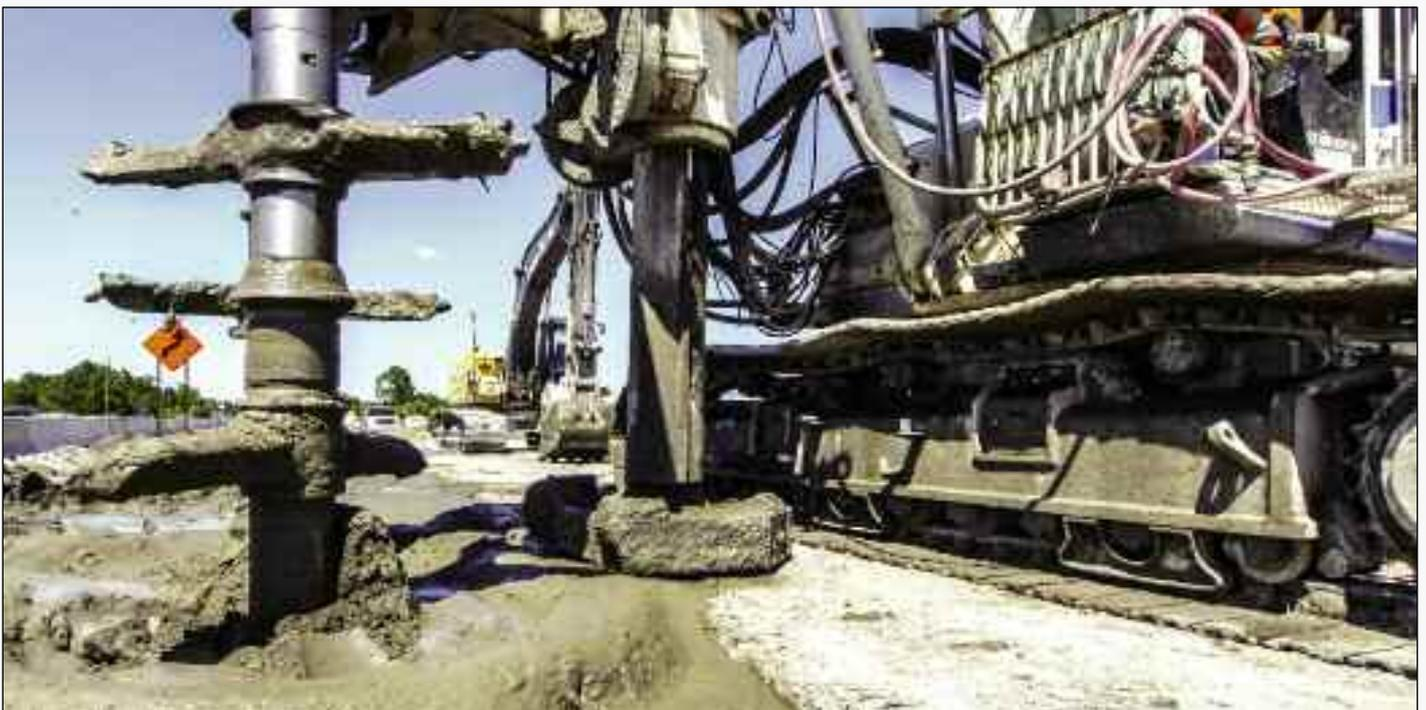
7. La SR-90 in versione TTM (TreviTurboMix) ha due sistemi di iniezione e due aste mosse da due rotory capaci di una coppia di 179 kN
